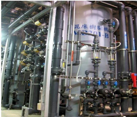
混床式離子交換樹脂塔
